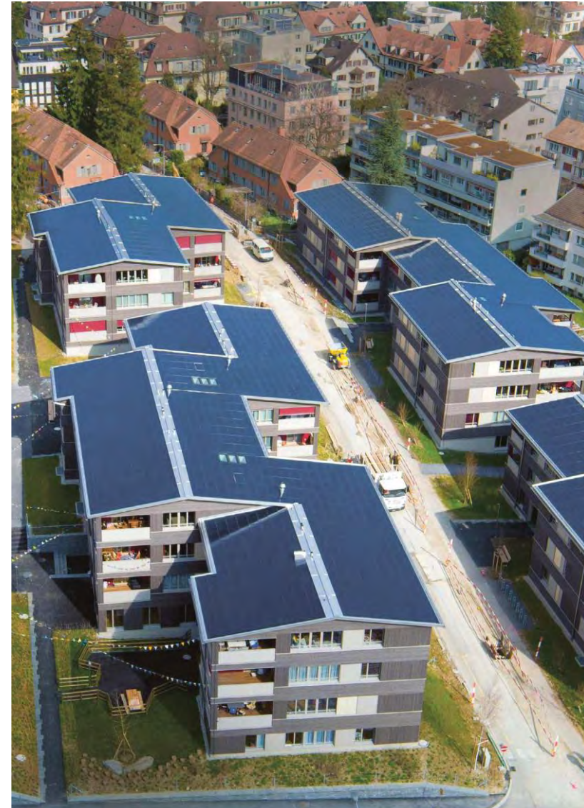
Lotissement de la Balberstrasse © Suntechnics Fabrisolar AG
