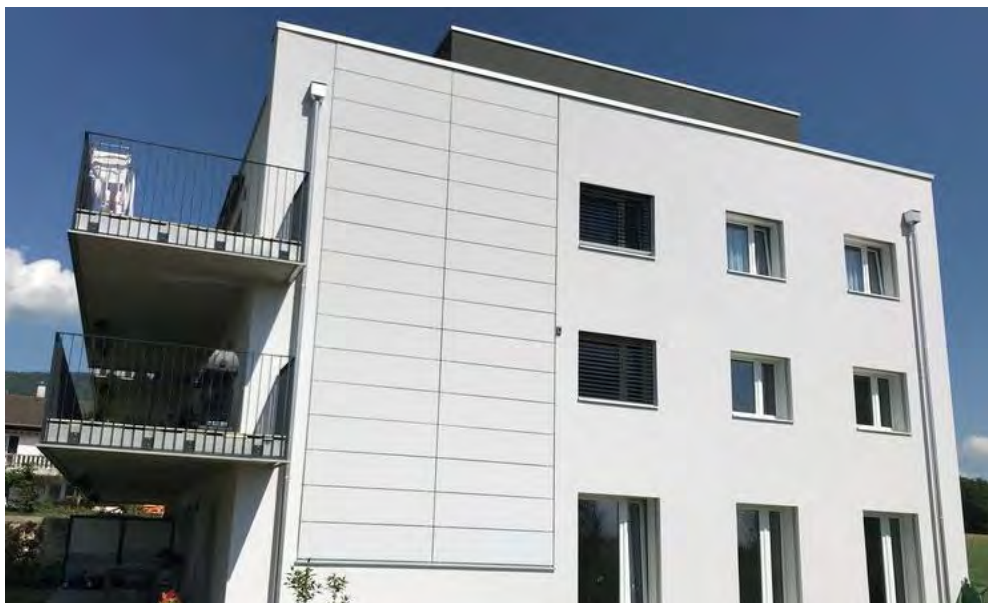
Immeuble à Boudry (NE) de Solaxess
