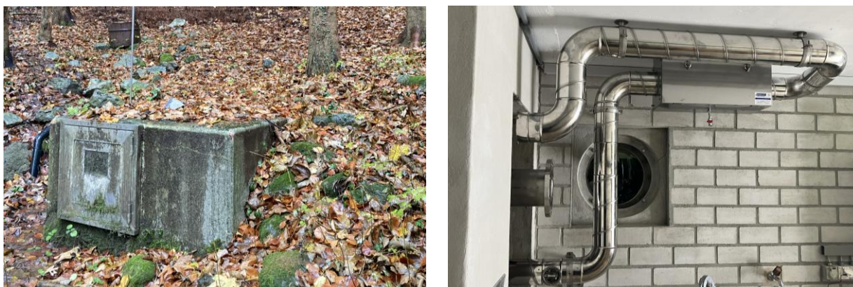
Figure 3 : Chambre de rassemblement démolie en décembre 2025 et nouvelle filtration de l'aération du réservoir de Daviaz
